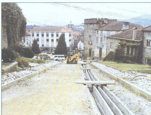
Rua da Fonte da Vila - Aspecto da colocação de valas técnicas
